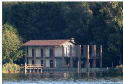
Edificio didattico (CEA) di educazione ambientale basata sulla natura circostante. Teaching facility (CEA) for environmental education based on the natural surroundings.
